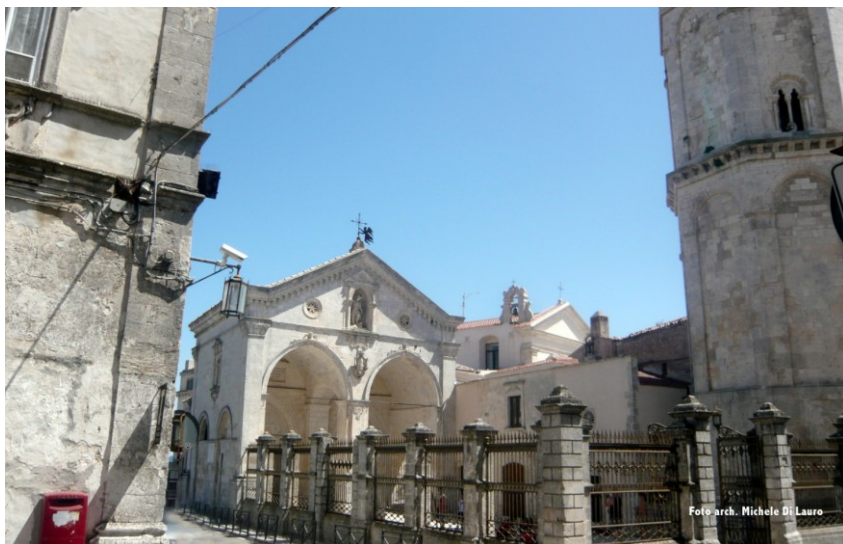
Fig. 2. Atrio superiore della Basilica di San Michele Arcangelo a Monte Sant'Angelo. Situazione attuale dell'area antistante la chiesa, che rispecchia in larga parte la ristrutturazione del piazzale (Atrio della colonna) e dell'ingresso avvenuta nel 1865.
